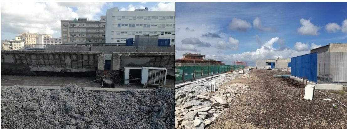
Allo stato attuale il pacchetto di finitura della copertura sulla quale andranno realizzati gli interventi in progetto, è composto da uno strato di tenuta costituito da una doppia membrana bituminosa, protetta da uno strato di separazione in TNT con finitura superficiale in ghiaino di
