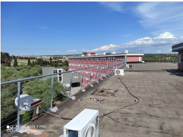
Nello stato attuale le coperture risultano sostanzialmente libere da attrezzature, a meno di alcuni componenti impiantistici puntuali quali i terminali delle cappe chimiche dei laboratori, o le unità esterne di sistemi a espansione diretta. Solo nel corpo centrale, in prossimità del braccio ovest, è presente un'UTA a servizio dell'edificio adiacente.
