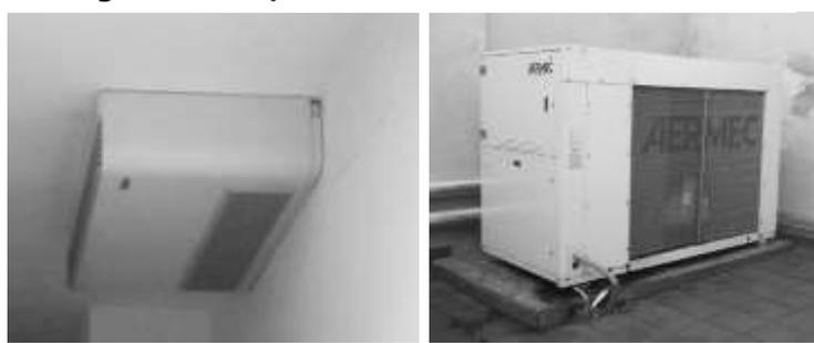
Per quanto concerne l'impianto di riscaldamento-raffrescamento, esso è centralizzato ed è di tipo a pompa di calore, la cui distribuzione avviene con tubi di rame, e i terminali installati sono dei fancoil a soffitto realizzati in
